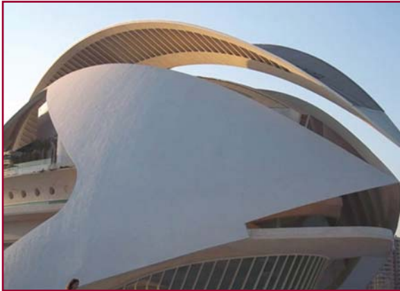
Construcción del Palau de les Arts (Valencia)
