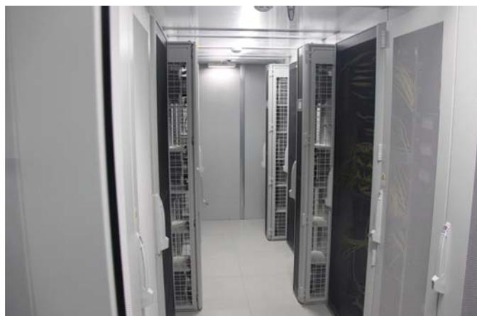
Esta estructura se ha construido con 12 racks Rittal TS IT, un sistema modular inteligente de racks y accesorios, con tecnología plug & play, que permite maximizar la eficiencia y simplificar el montaje, reduciendo costes, con los máximos niveles de flexibilidad, calidad y seguridad. El sistema se completa con un cerramiento que reduce el espacio a climatizar, limitándolo únicamente al pasillo frío.
