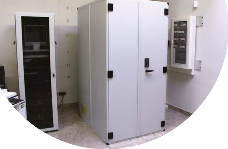
El sistema eléctrico se mejoró con un cuadro con protecciones magnetotérmicas y diferenciales superinmunitados, y PSM's que permiten la posibilidad de intercambio de módulos en caliente.
